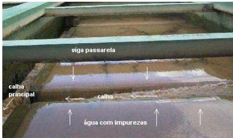
Lavagem de filtros. Na foto de cima o início (areia fluidificando) e na de baixo a lavagem em pleno funcionamento (observar o funcionamento das calhas coletoras)
